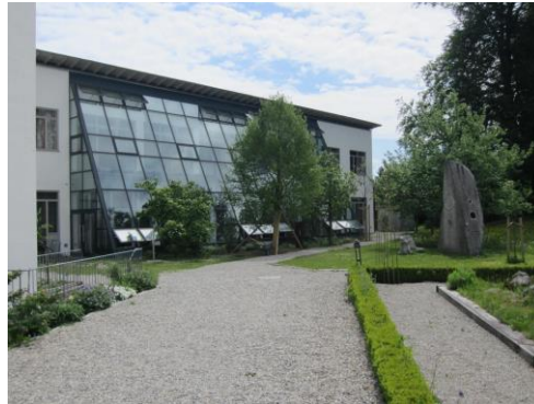
Neuer Gebäudeteil Rückansicht
