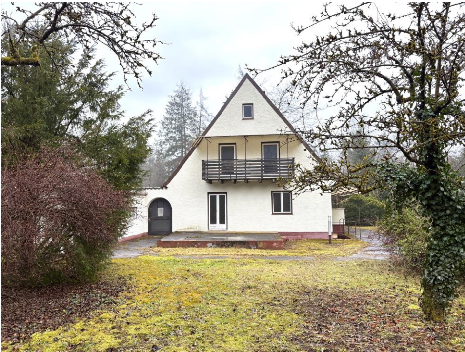
Südfassade und Garten
