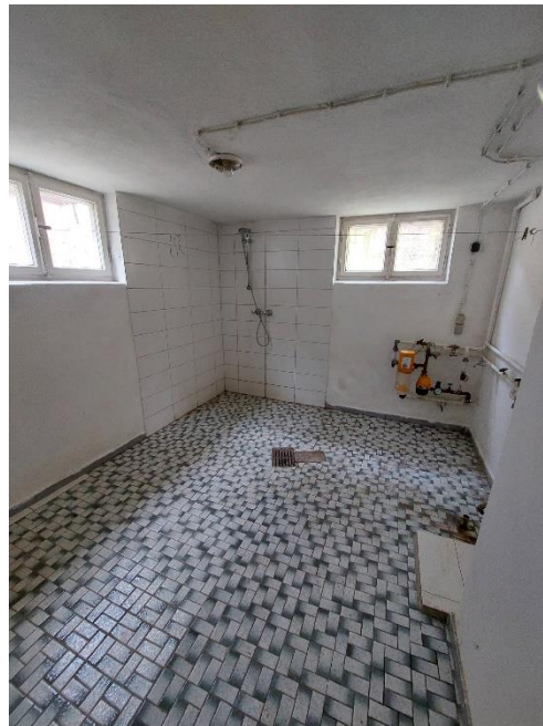
Waschküche mit Dusche
