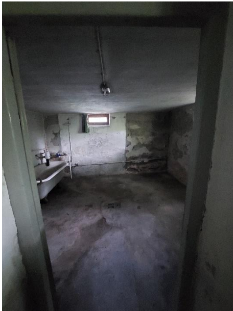
Kellerraum mit Badewanne
