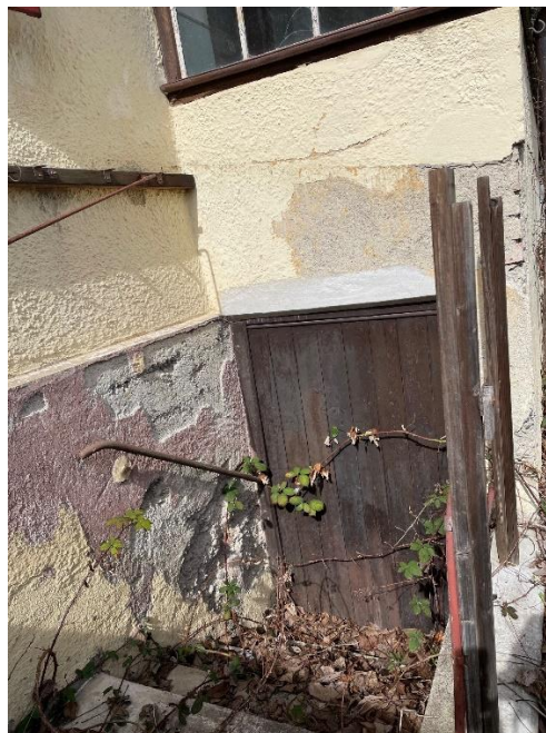
Zugang vom Garten in den Keller
